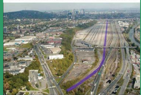
Photo 1990, vue vers l'est montrant dalles de la gare intermodale
